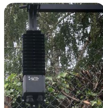
Exemple de montage d'un driver sur un support
